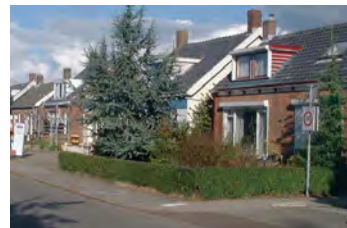
Toevoegingen en verandering van gevelindeling verstoren samenhang.
