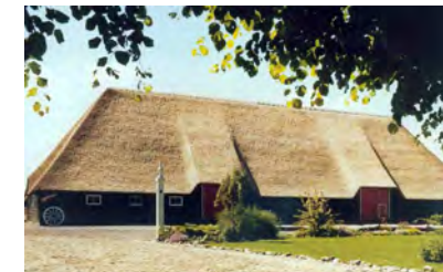
Schuur met schilddak en lage zijgevels. Het dakvlak is bij de mendeuren opgelicht.
