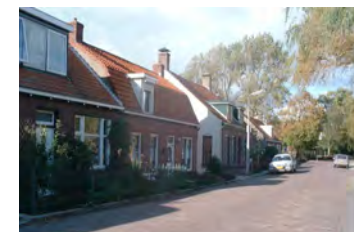
Samenhangende bebouwing van een laag en evenwijdige kap.
