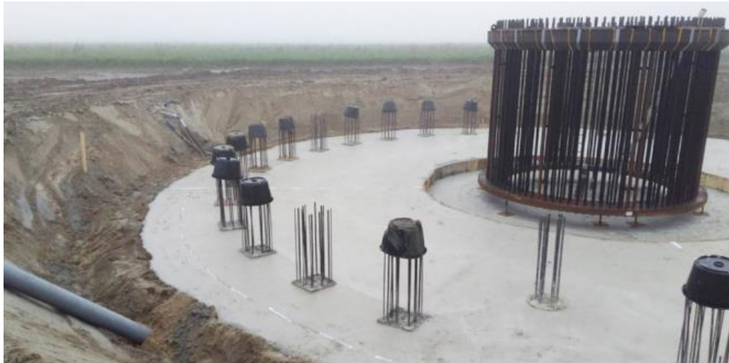
Figuur 3.2 Ankerkooi en wapeningsstaal heipalen
